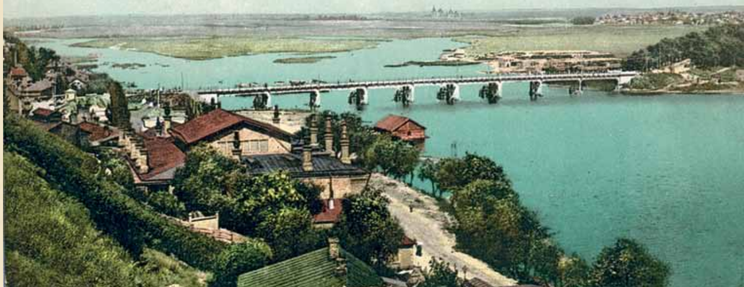
Мост через реку Воронеж
